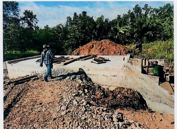
โครงการก่อสร้างท่อลอด ( BOX CULVERT ) ๒x๑.๘๐x๑.๘๐x๘.๐๐ เมตร ซอยริมคลองน้ำแดง หมู่ที่ ๖ ตำบลน้ำจืดน้อย จังหวัดระนอง
