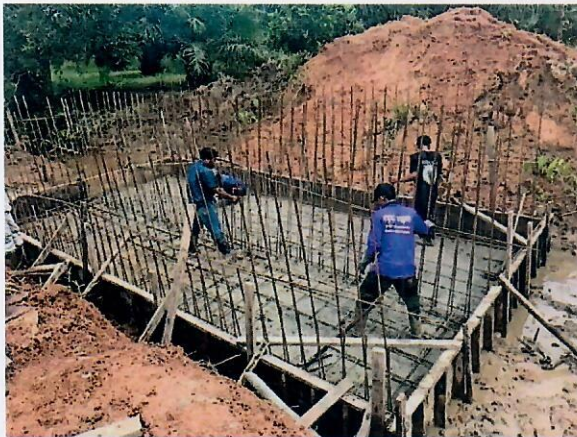
โครงการก่อสร้างท่อลอด ( BOX CULVERT ) ๒x๑.๘๐x๑.๘๐x๘.๐๐ เมตร ซอยริมคลองน้ำแดง หมู่ที่ ๖ ตำบลน้ำจืดน้อย จังหวัดระนอง
